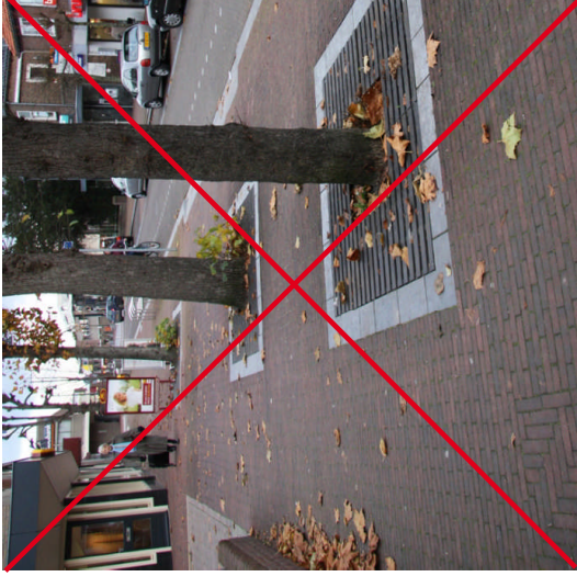
boomrooster Biесе - verdeler Anae - materiaal gietijzer
