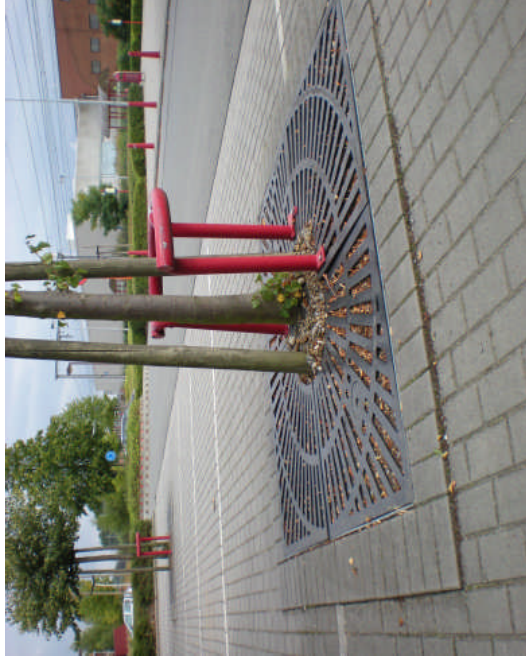
Vichte - stationplein variant 1: boomrooster Budenus - verdeler Wolters - gietijzer variant 2: boomrooster Bell Italia - verdeler Velopa - gietijzer
