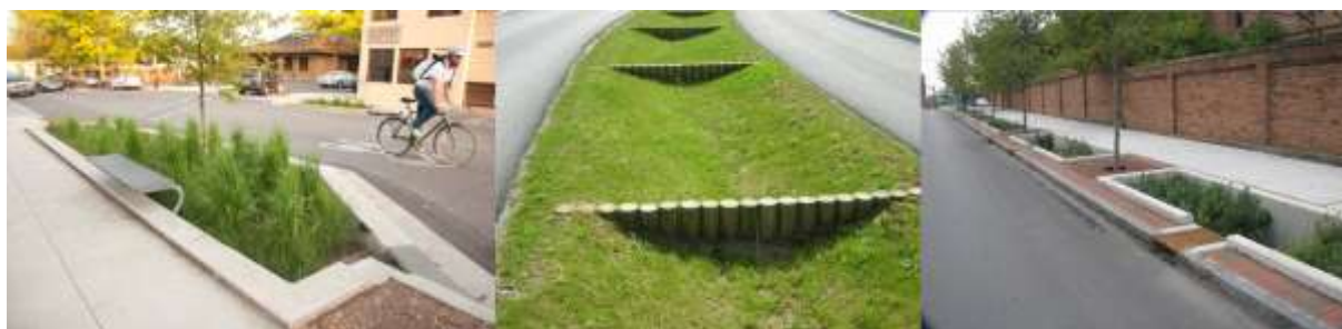
Foto 7 Voorbeelden van lokale buffers/infiltratievoorzieningen. Zo kunnen reeds bestaande verkeers-elementen ook een waterfunctie vervullen en voorzien in infiltratie en buffering op straatniveau (Bron links: Clay street door Green Works).
