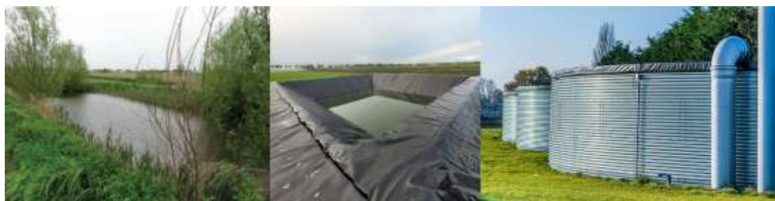
Figuur 26: vlnr: 1) Open bufferbekken. Bron: Aquafin. 2) Foliebassin. Bron: Inagro. 3) Watersilo. Bron: Waterportaal.
