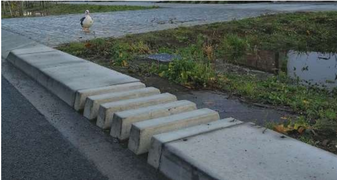
Foto 4 Een voorbeeld van een boordsteen met splaten zoals toegepast in de Fortstraat in Mortsel (Bron: dbpubliekeruimte.info).
