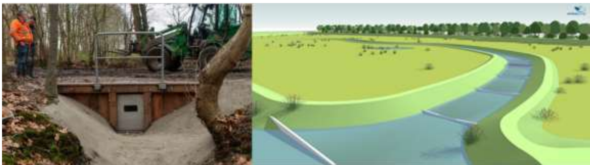
Figuur 45. Links) Regelbare knijpstuw Ulvenhouts bos (Nederland). Bron: Naturetoday.com. Rechts) Vispasseerbare drempels in waterloop afwaarts van natuurgebied. Zo wordt opstuwning gecreëerd zonder dat een vismigratieknelpunt ontstaat. Dit principe werd toegepast bij de herinrichting van 'de Hellekens' in Herentals. Bron: VMM.
