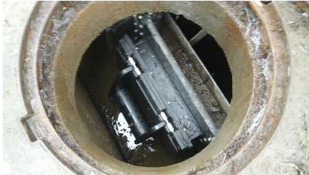
Figuur 50: Terugslagklep op overstortdrempel. Bron: Aquafin.
