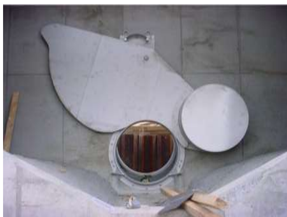
Figuur 49: Links: Debietregelaar. Bron: Morselt.com. Rechts: Regelbare afsluiter. Bron: KWT.be.
