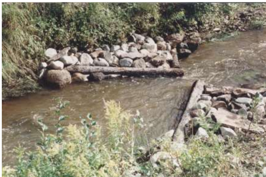
Foto 17 Stroomdeflector met stenen en hout. Bron: www.afterwildfire.org .
