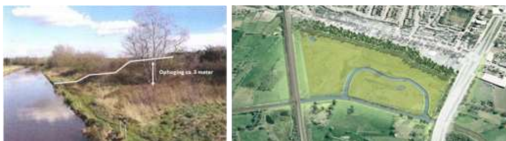
Figuur 44: Herinrichting 'Hellekens' te Herentals d.m.v. afgraven talud. Bron: VMM.
