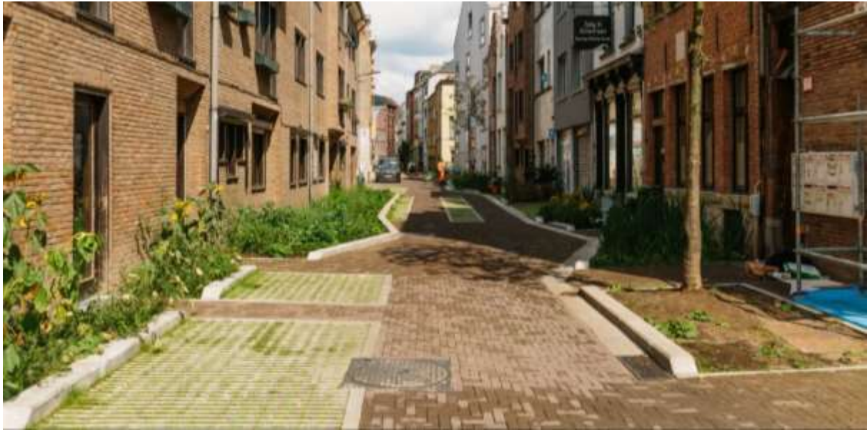
Foto 3 Voorbeeld van de toepassing van halfverharding voor parkeervakken in de Tuinstraat (Lange Ridderstraat) in Antwerpen (Bron: Stad Antwerpen).
